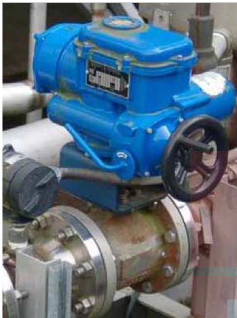
*Figura 139: Actuador eléctrico.*
